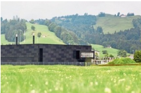
Das TIER IV-Level zertifizierte Rechenzentrum Ostschweiz (RZO) in Gais AR (Foto: SAK).
