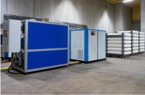
Der Druckluft-Energiespeicher der Green-Y Energy AG speichert Strom mithilfe einer patentierten Druckluft-Technologie und erzeugt dabei zusätzlich Wärme und Kälte. Das System arbeitet ausschliesslich mit Luft und Wasser, verwendet keine seltenen Rohstoffe und ist zu 100 % recycelbar. / © Green-Y Energy AG
