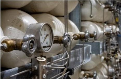
Druckluft-Energiespeicher weisen mit rund zwanzig Jahren eine längere Lebensdauer als Lithium-Ionen-Batterien auf. Die Lebensdauer der Speicherflaschen beläuft sich auf bis zu 50 Jahre. / © Green-Y Energy AG
