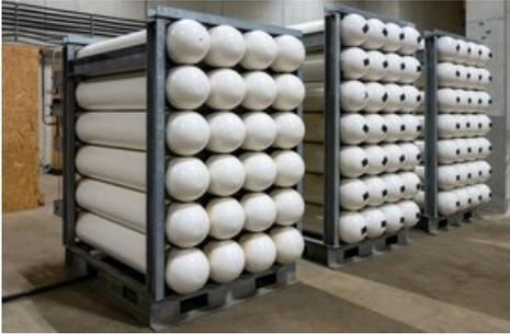
In solchen Druckluftflaschen wird die komprimierte Luft mit bis zu 300 bar gespeichert. / © Green-Y Energy AG
