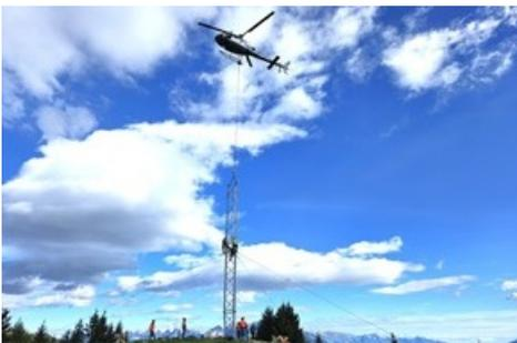
Installation des 80 Meter hohen Messmasts auf dem Grot – St. Margrethenberg (Bild: SAK).
