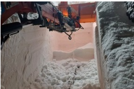
Damals wie heute ein spektakuläres Vorhaben: Der Schneebruch auf der Zahnradbahnstrecke am Pilatus erfordert vollen Einsatz in anspruchsvollem Terrain. © Pilatus-Bahnen AG
