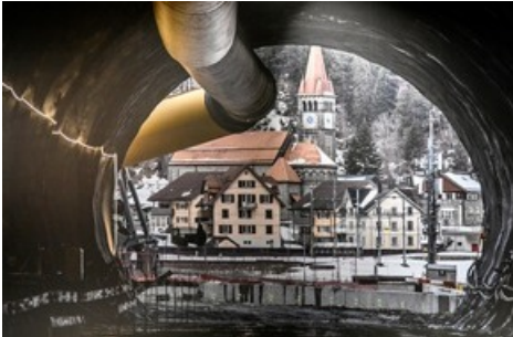
Neue Ausstellung zum Bau der zweiten Röhre für den Gotthard-Strassentunnel
