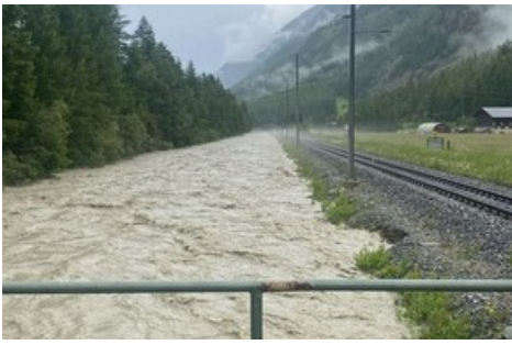
Hochwassersituation inneres Mattertal
