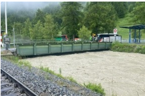
Hochwassersituation inneres Mattertal
