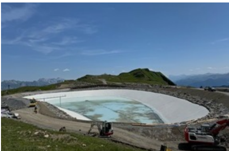
Die ersten Kubikmeter Wasser bedecken den Grund des neuen Speichersees
