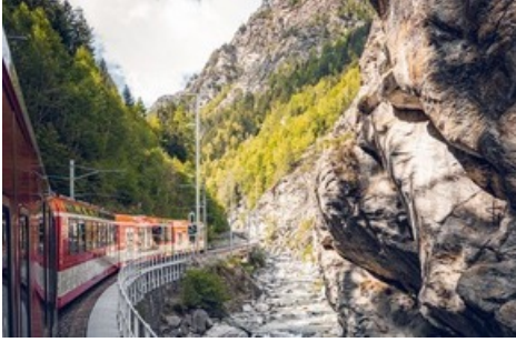
Zug der Matterhorn Gotthard Bahn auf dem Abschnitt zwischen Stalden und St. Niklaus
