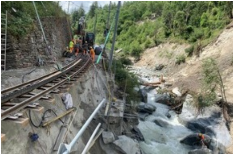
Anspruchsvolle Instandstellungsarbeiten des Geleises der Matterhorn Gotthard Bahn in der Kipfenschlucht.
