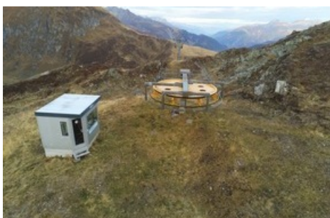
Bergstation Val Val. Baugesuch eingereicht
