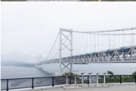
Ein architektonisches Meisterwerk: Die Grosse Seto-Brücke verkörpert drei Formen der Bautechnik: Schrägseil-, Hänge- und Fachwerkbrücke. © JOMC
