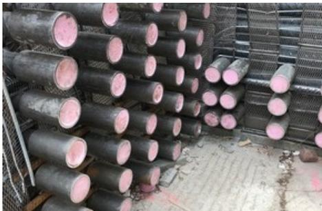
Le recouvrement conventionnel des armatures ne pouvant pas être réalisé, les responsables du projet ont opté pour une solution avec liaisons d'armatures par filetage BARTEC®. Texte complémentaire par ots et sur [www.presseportal.ch/fr/nr/100053189](http://www.presseportal.ch/fr/nr/100053189) / L'utilisation de cette image est pour des buts rédactionnels gratuite. Publication sous indication de source: "obs/Debrunner Acifer AG/zvg"
