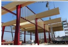
L'imposante structure mixte bois/acier de la halle : 24 colonnes creuses coniques en acier de 13 m de haut et 24 fermes en bois, chacune de 2 m de haut et 36 m de long. / Texte complémentaire par ots et sur www.presseportal.ch/fr/nr/100053189 / L'utilisation de cette image est pour des buts redactionnels gratuite. Publication sous indication de source: "obs/Debrunner Acifer AG/Copyright: Debrunner Acifer AG/"
