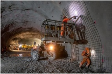
Durant les travaux (S. Irngartinger / BLS).
