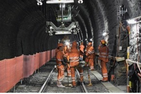
Travaux de construction dans le tunnel de façade du Lötschberg
