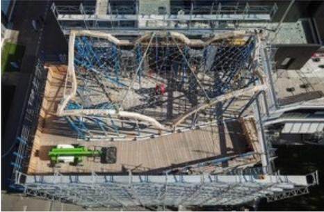
Un treillis en câbles d'acier sert de structure de support au toit bombé en béton léger fibré. / Texte complémentaire par ots et sur [www.presseportal.ch/fr/nr/100066396](http://www.presseportal.ch/fr/nr/100066396) / L'utilisation de cette image est pour des buts rédactionnels gratuite. Publication sous indication de source: "obs/Debrunner Acifer AG Bewehrungen/Photo by Juney Lee"
