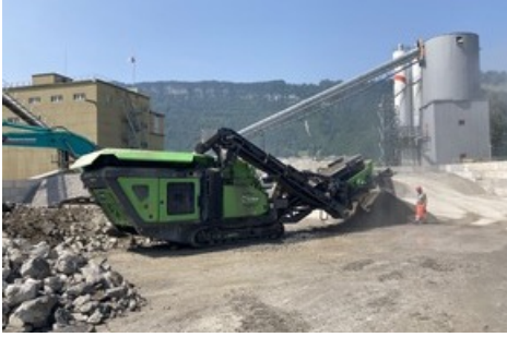
Site de recyclage du consortium EvoREC à Oberdorf
