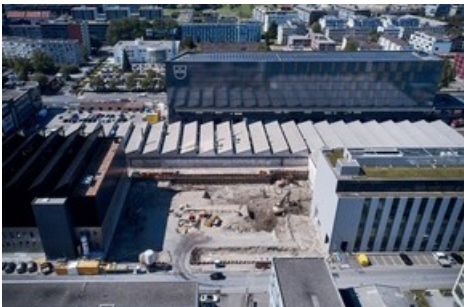
Vue aérienne du chantier. Crédit photo: Tech Cluster Zug AG.
