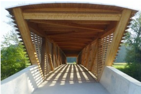
Le pont de Neumattbrücke à Berthoud | Source : Haute école spécialisée bernoise
