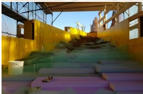
Le modèle en cours de construction / Haute école spécialisée bernoise
