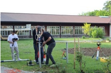
Percer des trous pour la fondation.
