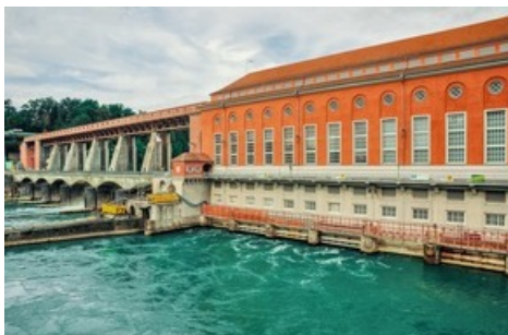
Centrale hydroélectrique à Eglisau, Suisse
