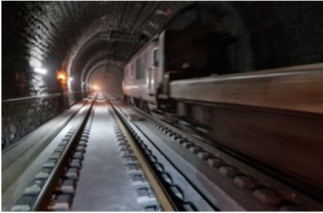
voie ferrée en béton dans le tunnel de faîte du Lötschberg (source: BLS)
